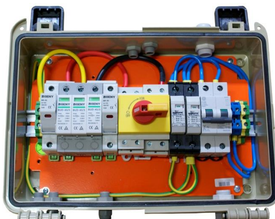
Figura 15 – String box , contendo: chave seccionadora, DPS, fusíveis e disjuntor.
