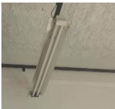
Figura 6.4 – Luminária danificada
