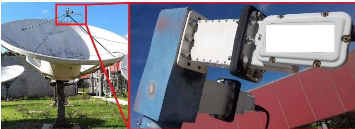
Figura 4 - LNBs horizontal e vertical conectados a um alimentador.
