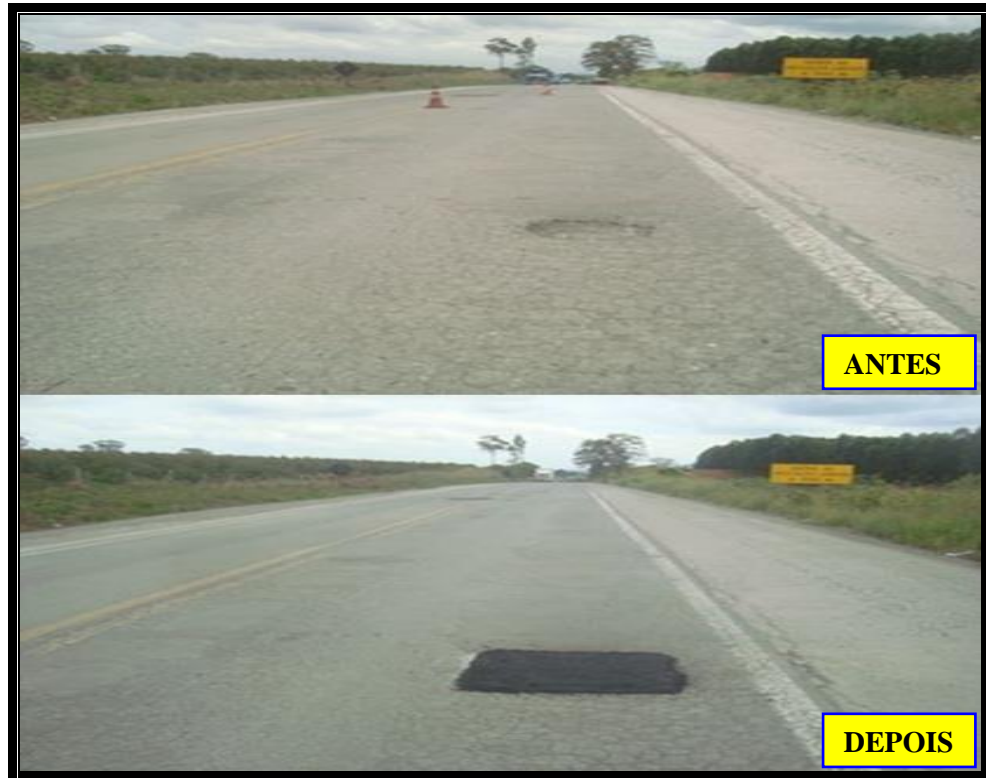
Figura 7.5 - Serviço emergencial de tapa-buraco Fonte: Autoria própria (2011)
