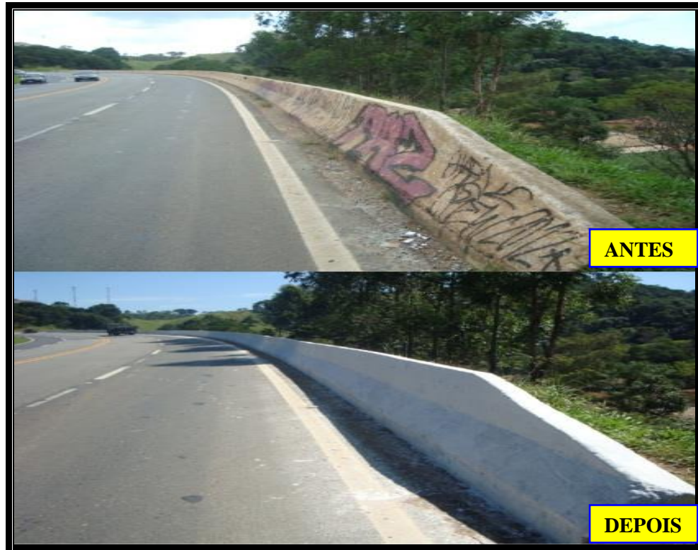
Figura 7.3 - Serviço de pintura com cal Fonte: Autoria própria (2011)
