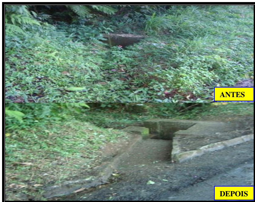
Figura 7.2 - Serviço de limpeza de bueiro Fonte: Autoria própria (2011)
