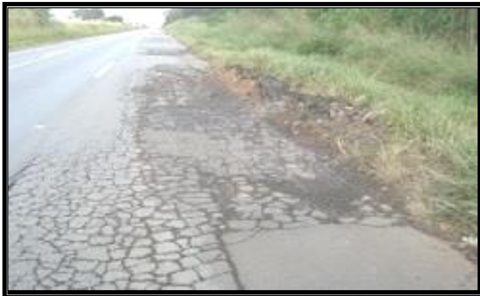
Figura 4.2 - Trinca couro de jacaré; escorregamento plástico
