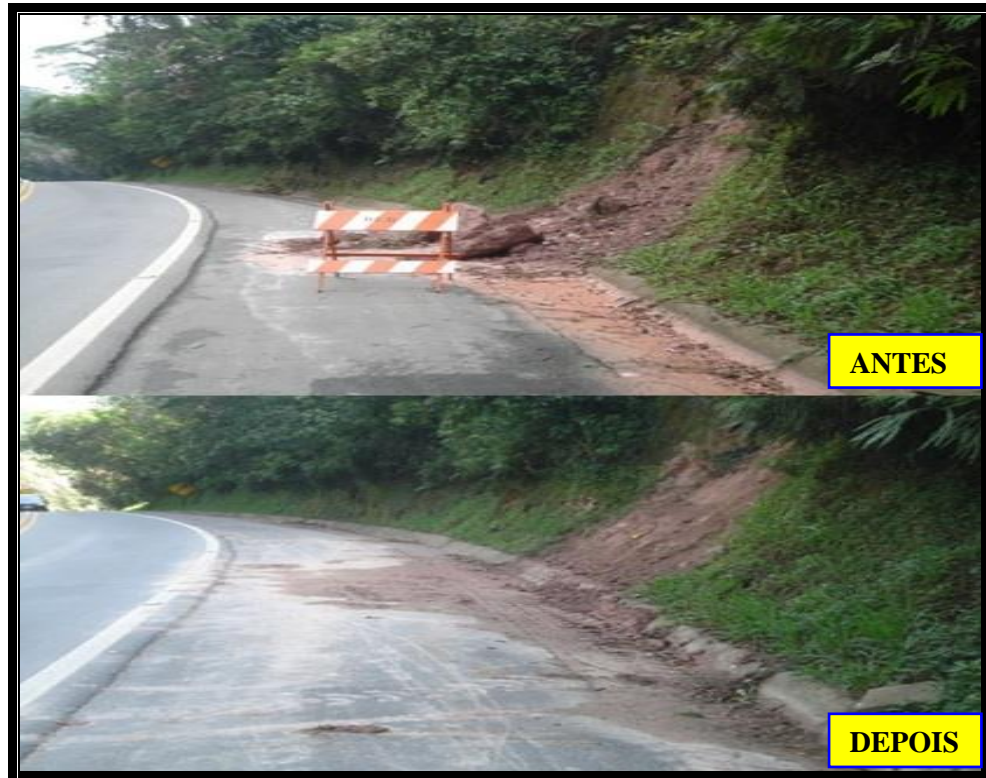
Figura 7.1 - Serviço de remoção manual de barreira Fonte: Autoria própria (2011)
