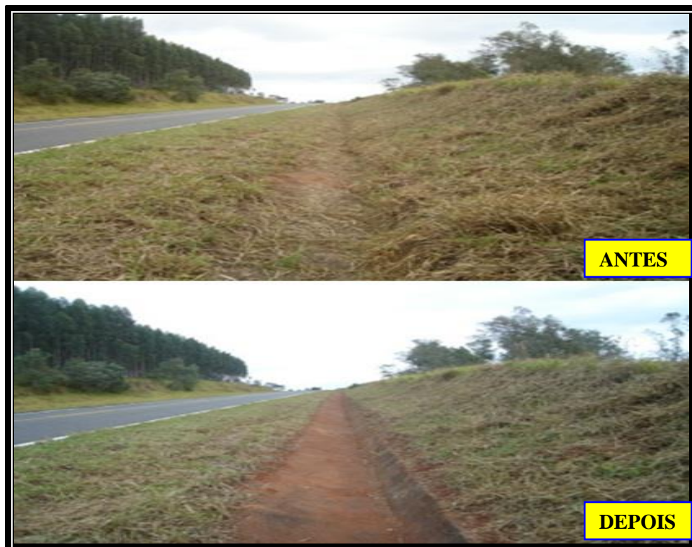
Figura 7.4 - Serviço de limpeza de canaleta de drenagem Fonte: Autoria própria (2011)
