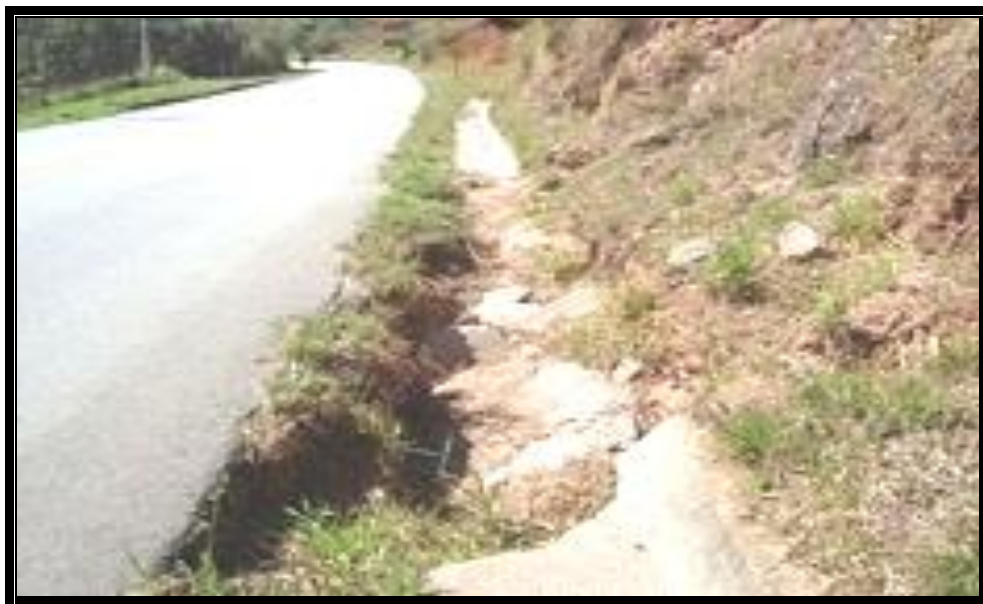
Figura 4.3 - Canaleta deteriorada
