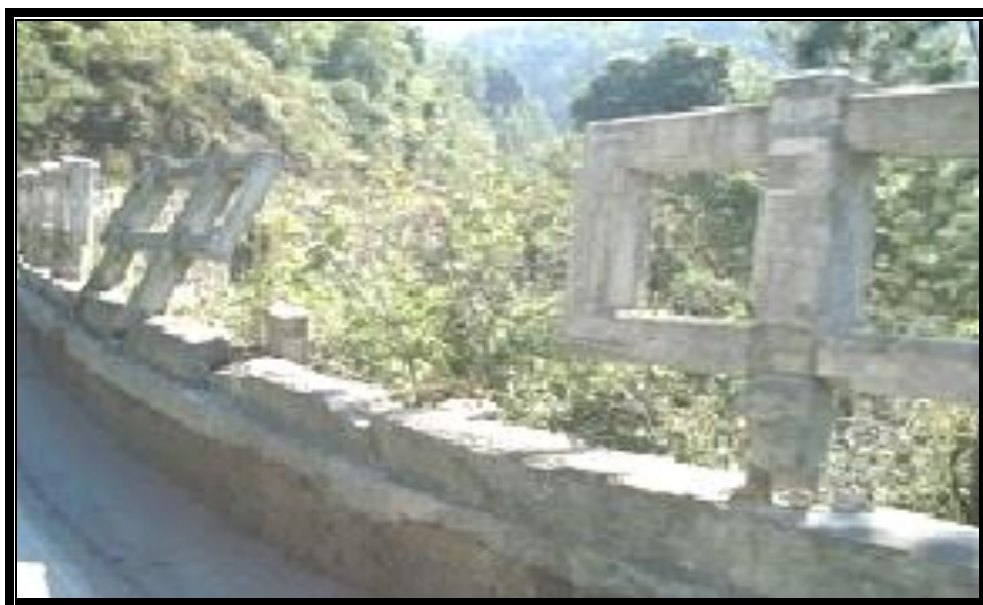
Figura 4.4 - Guarda corpo danificado
