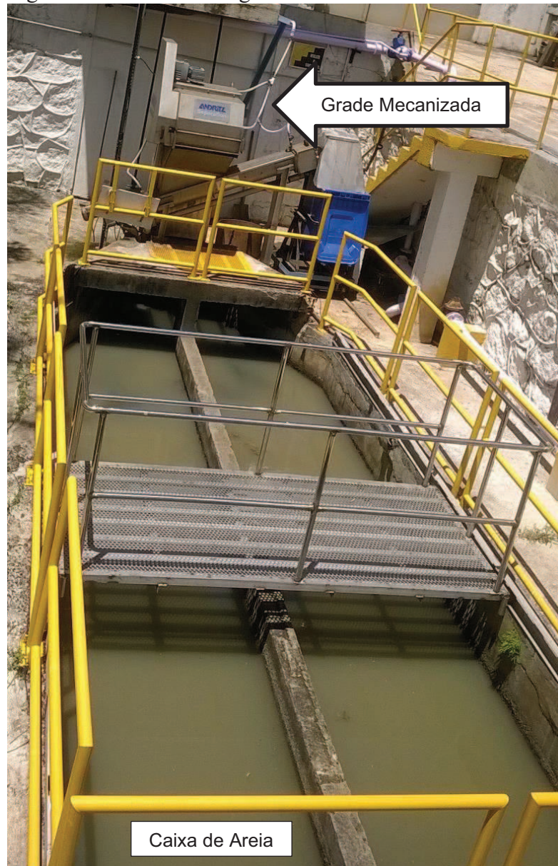
Figura 17 - Entrada do esgoto bruto – Tratamento Preliminar
