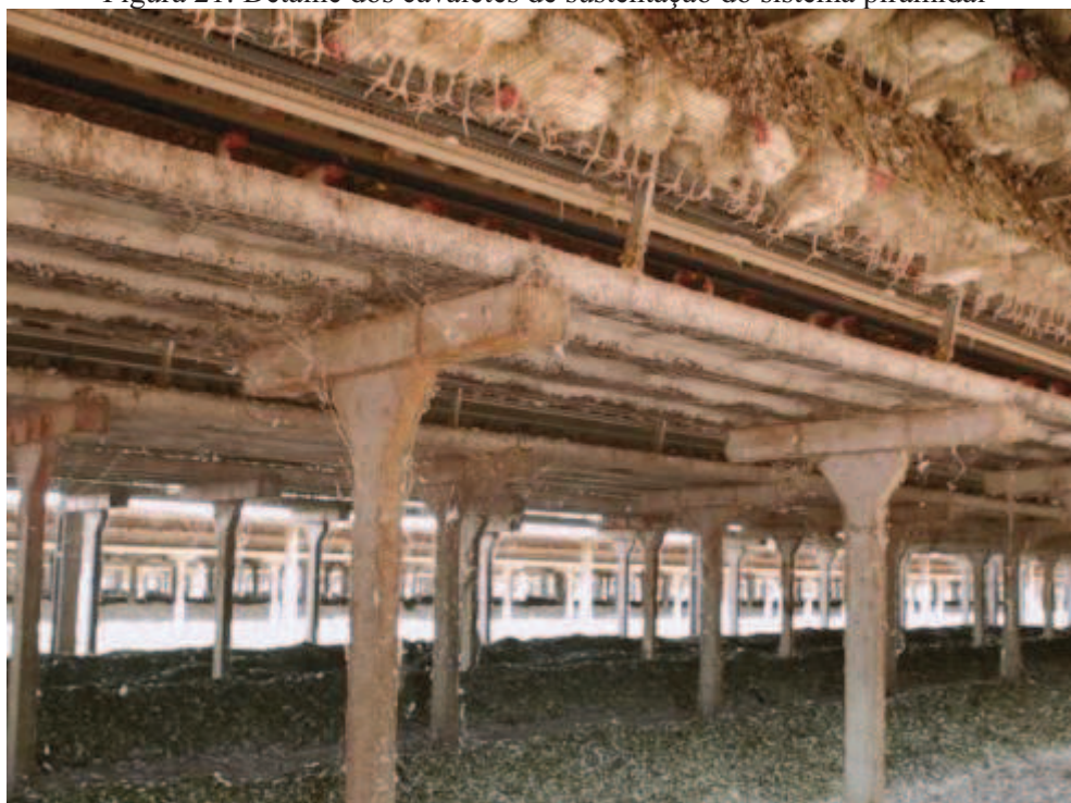
Figura 21: Detalhe dos cavaletes de sustentação do sistema piramidal
