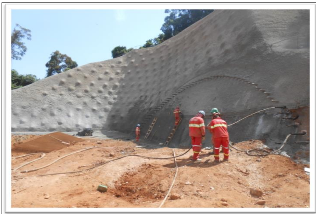
Figura 7.5 Emboque de Túnel em Execução Fonte: PRÓPRIA (2014)
