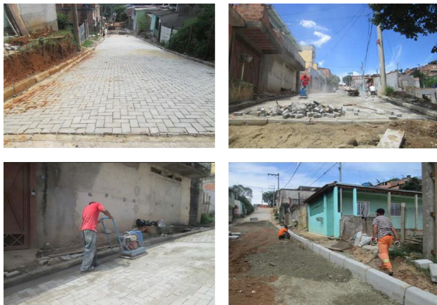
Figura 7.8 Regularização do pavimento do Caminho de Serviço do Rodoanel – Trecho Norte – Lote 4 Fonte: FALCÃO BAUER (2014)
