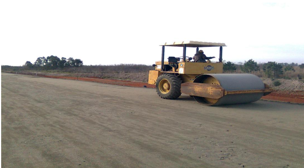
Figura 2.5: Execução de camada de base Fonte: PRÓPRIA (2013)
