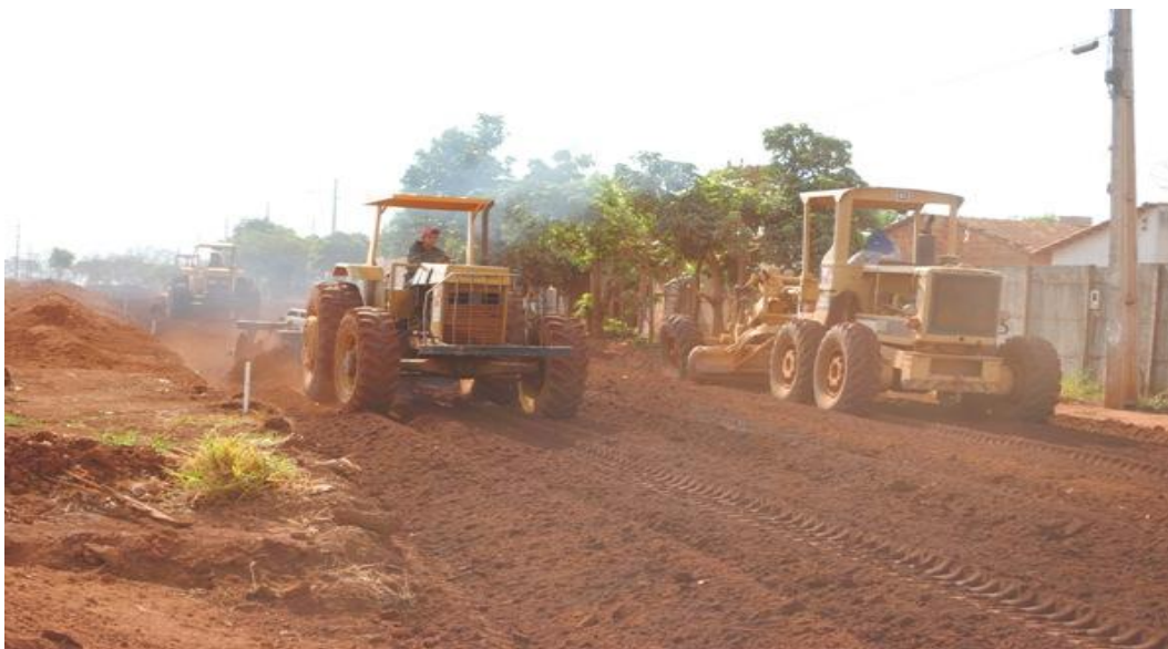
Figura 2.2: Camada de Regularização Fonte: PRÓPRIA (2013)
