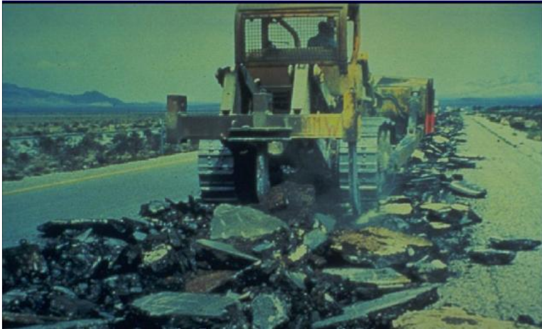
Figura 4.8: Remoção da camada de pavimento Fonte: DAU (2001)
