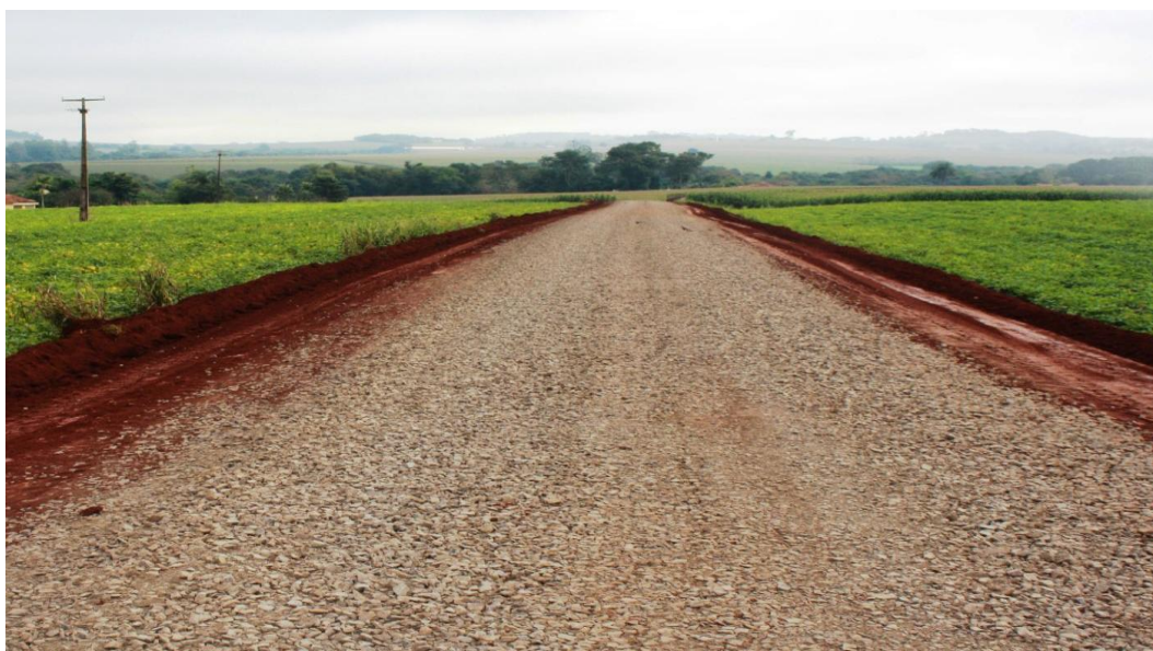
Figura 2.3: Reforço do Subleito Fonte: PRÓPRIA (2014)
