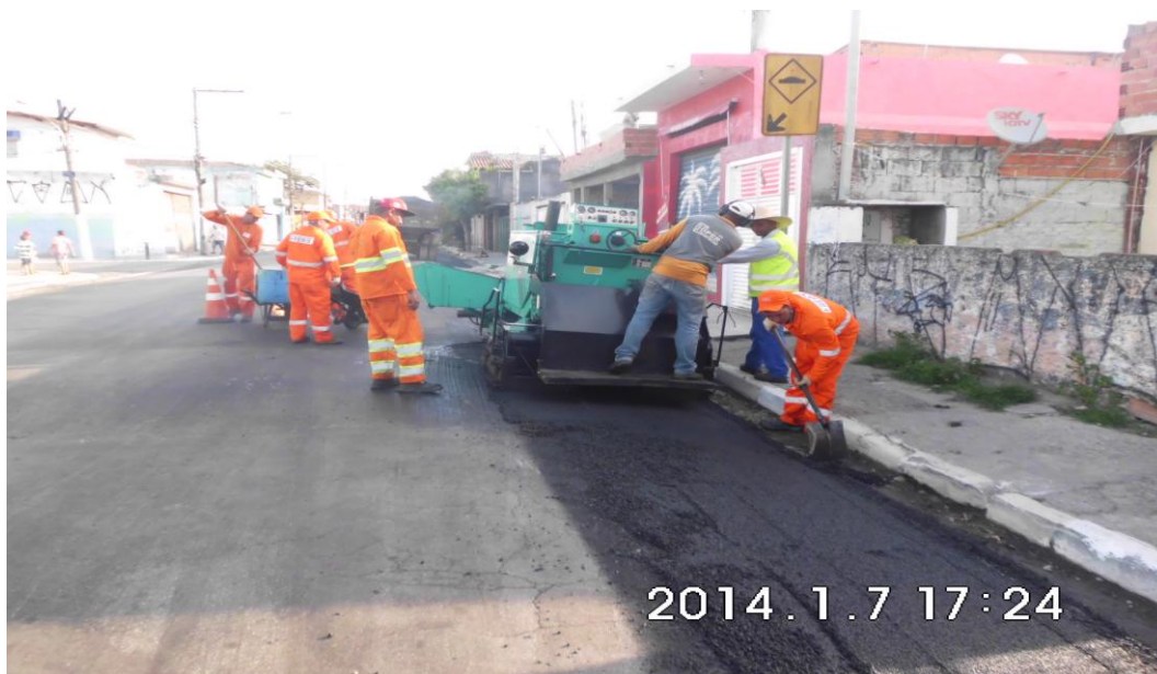
Figura 2.6: Execução de camada de revestimento Fonte: PRÓPRIA (2014)
