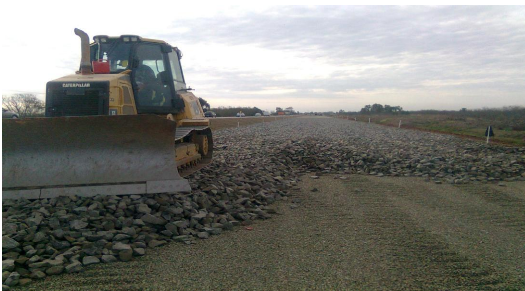
Figura 2.4: Execução de camada de sub-base Fonte: PRÓPRIA (2013)
