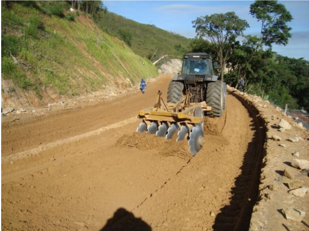
Figura 3.3 – Melhoria e Preparo do subleito Fonte: PRÓPRIA (2013)
