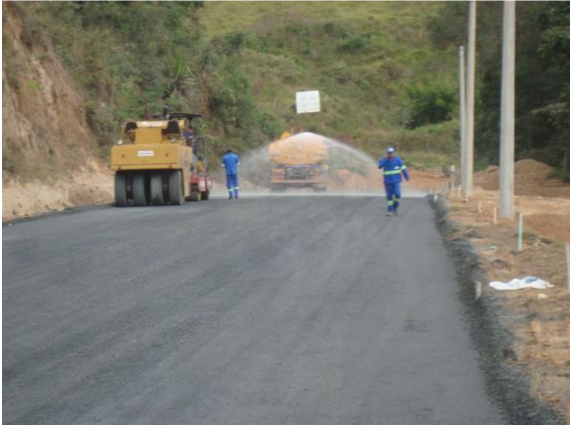
Figura 3.4 – Compactação da base Fonte: PRÓPRIA (2013)
