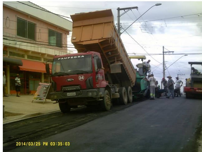
Figura 8.8: Aplicação da CBUQ com auxílio da acabadora. Fonte: ENGº JOSÉ MARIA CORDEIRO (2014).
