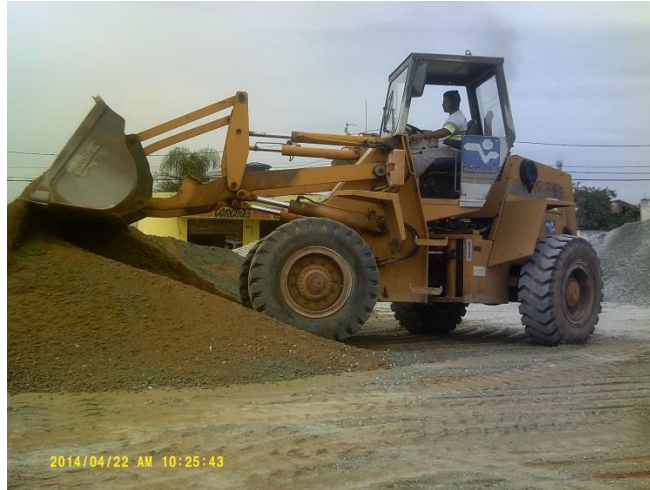
Figura 8.2 - Mistura de agregado reciclado com BGS convencional na obra Fonte: ENG° JOSÉ MARIA CORDEIRO (2014).
