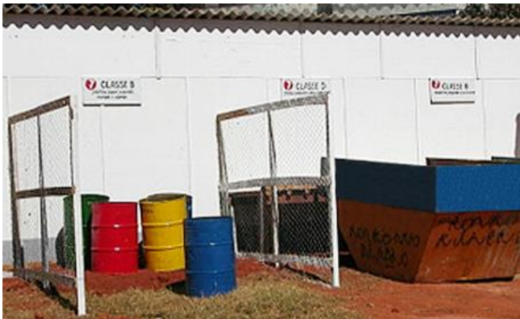
Figura 4.19 - Baías para armazenamento de resíduos segregados Fonte: BLUMENSCHN, RAQUEL NAVES (2007).
