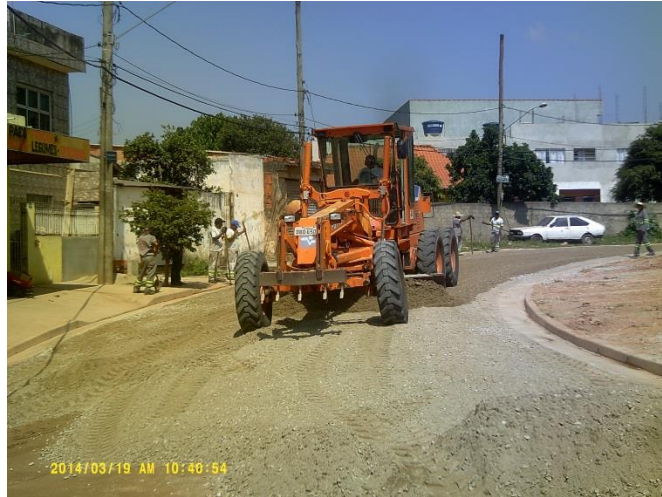
Figura 8.5 - Regularização da base com o auxílio da motoniveladora. Fonte: ENGº JOSÉ MARIA CORDEIRO (2014).
