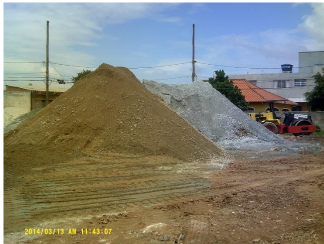
Figura 8.3 - Base estocada, com mistura de agregado reciclado e BGS convencional na obra. Fonte: ENG° JOSÉ MARIA CORDEIRO (2014).
