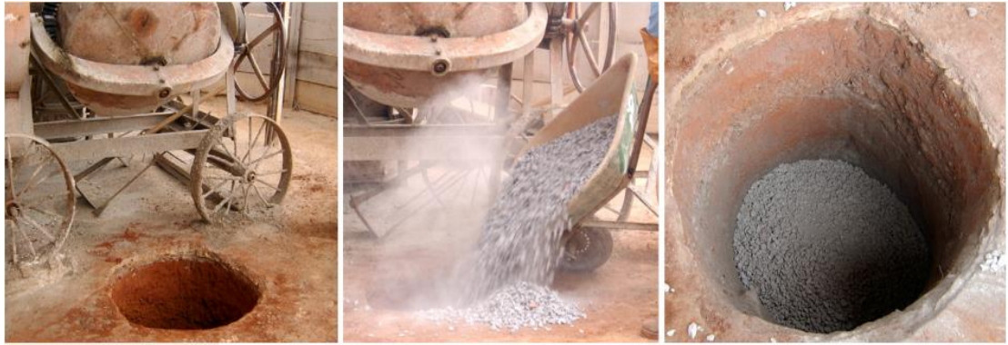
Figura 4.14 –Construção do filtro da água proveniente da lavagem da betoneira Fonte: BLUMENSCHNEIN, RAQUEL NAVES (2007).
