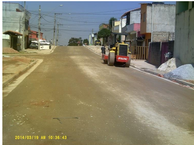
Figura 8.6: Compactação da base com auxílio do rolo liso vibratório. Fonte: ENGº JOSÉ MARIA CORDEIRO (2014).
