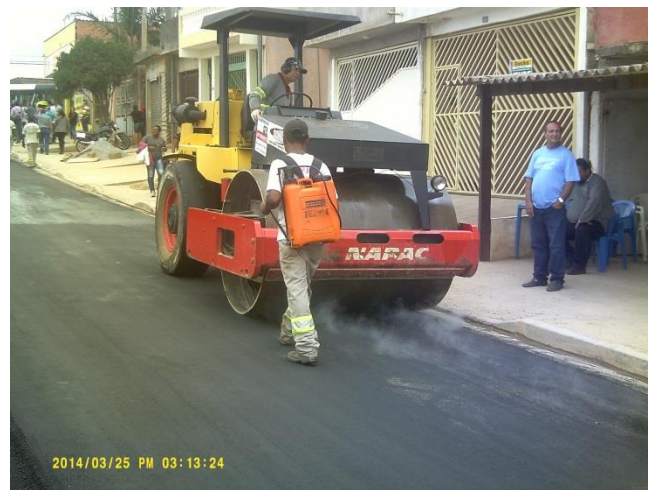
Figura 8.9 - Compactação do revestimento CBUQ. Fonte: ENGº JOSÉ MARIA CORDEIRO (2014).
