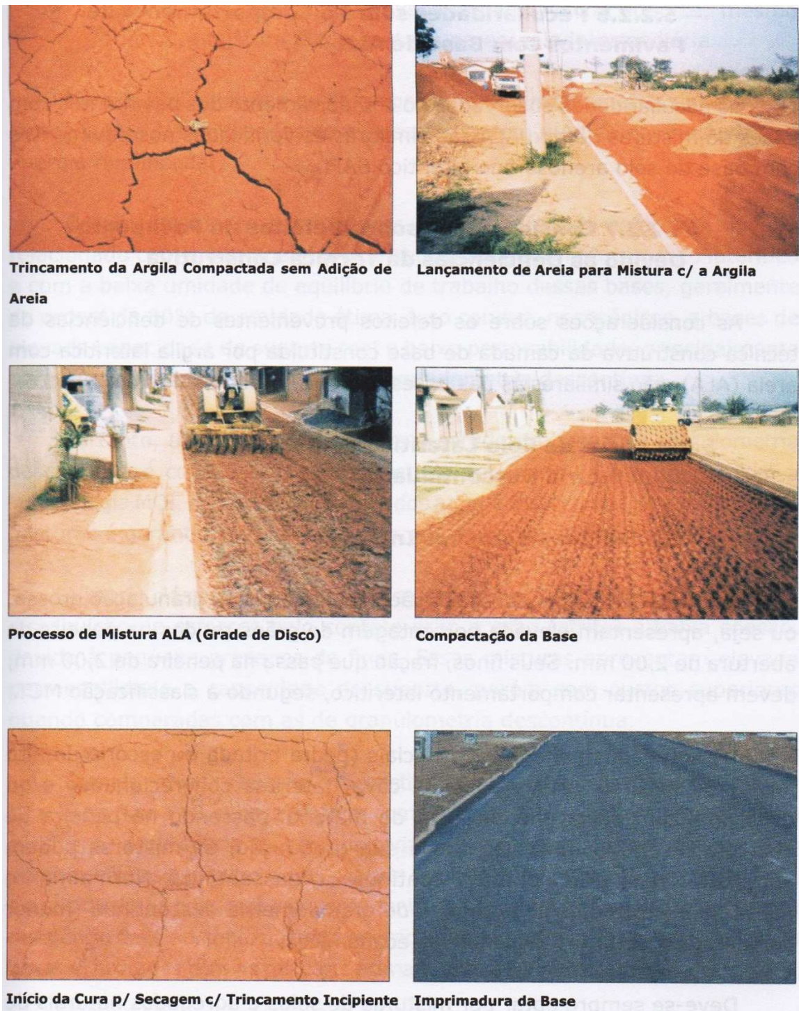
Figura 5.5 - Etapas construtivas de Bases de ALA Fonte: VILLIBOR et al. (2009)
