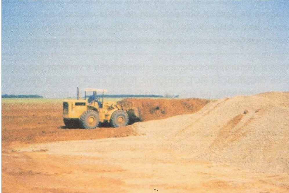
Figura 5.4 - Mistura de Argila e Areia com Pá Carregadeira Fonte: VILLIBOR et al. (2009)
