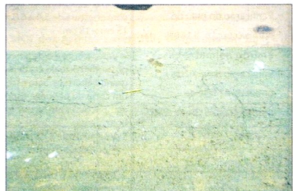
Reflexão de Trinca no Revestimento
