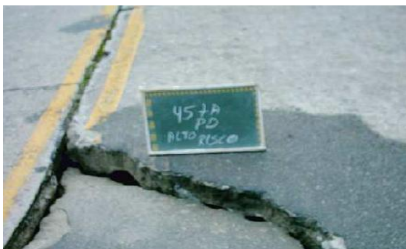
Figura 4.7 – Quebra Parcial do Pavimento de Concreto Fonte: MACHADO (2010, p.81)
