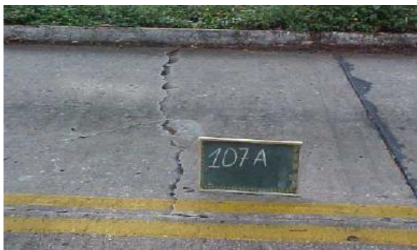
Figura 4.5 – Problemas com as Juntas do Pavimento de Concreto Fonte: MACHADO (2010, p.76)
