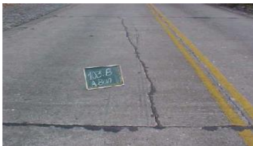
Figura 4.3 – Desnivelamento do Pavimento de Concreto Fonte: MACHADO (2010, p.76)
