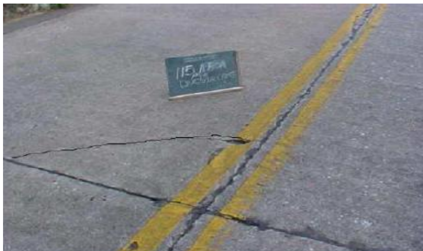
Figura 4.4 – Fissura no Pavimento de Concreto Fonte: MACHADO (2010, p.73)
