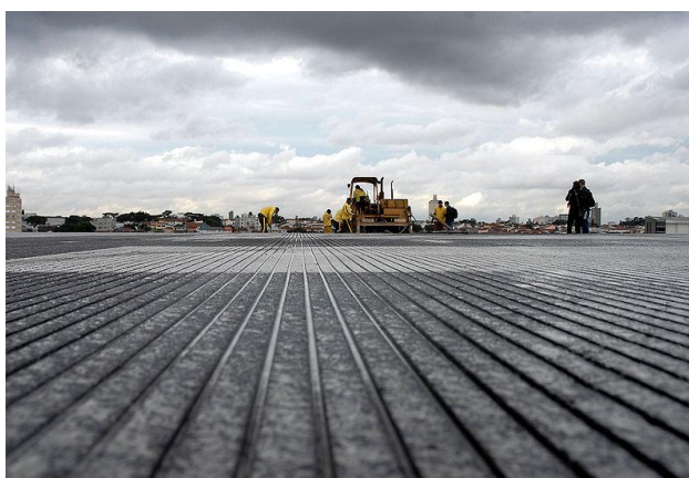
Figura 2.1 - Grooving (as ranhuras) aplicadas na pista do Aeroporto de Congonhas Fonte: SILVA (2008)
