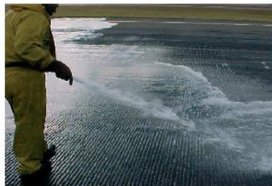
Figura 5.5 – Lavagem da pista após o desemborramento
