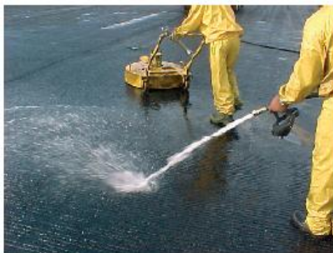
Figura 5.5 – Lavagem da pista após o desemborramento
