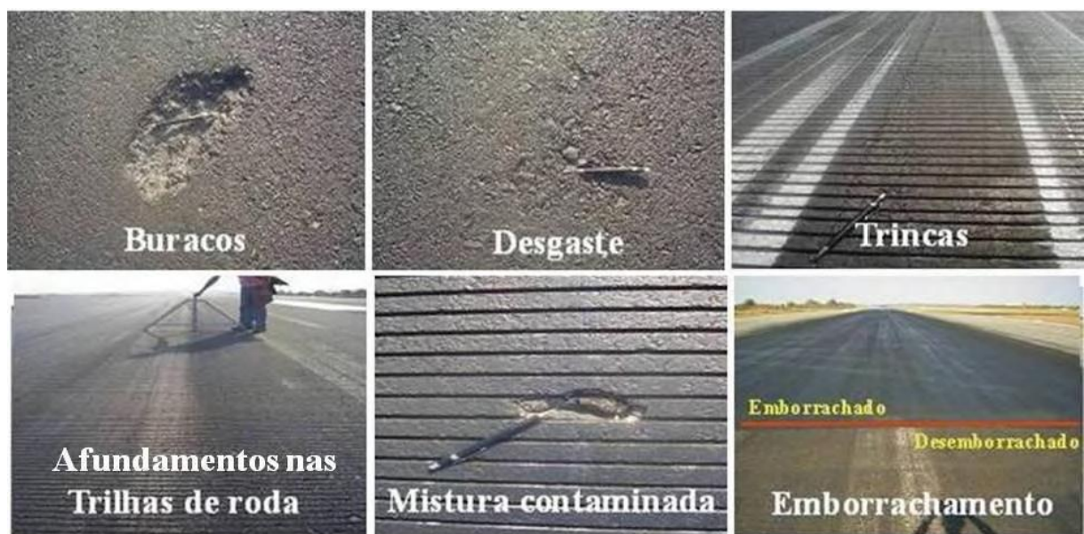
Figura 4.1 – Defeitos encontrados na pista antiga do AIB Fonte: SILVA (2008)
