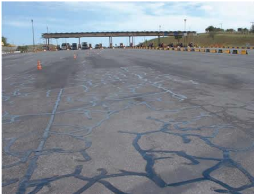
Figura 3.1: Material Selante já aplicado na pista Fonte: GOUVEIA (2012)
