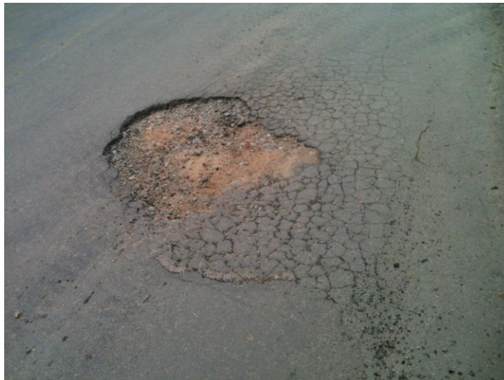
Figura 2.8: Panela atingindo a base Fonte: PRÓPRIA (2012)
