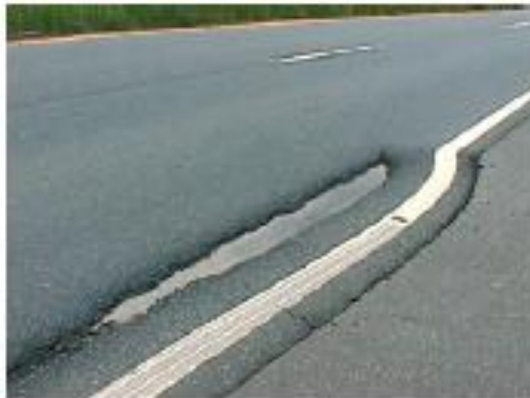
Figura 2.9: Escorregamento de revestimento asfáltico Fonte: BERNUCCI, et al. (2008)
