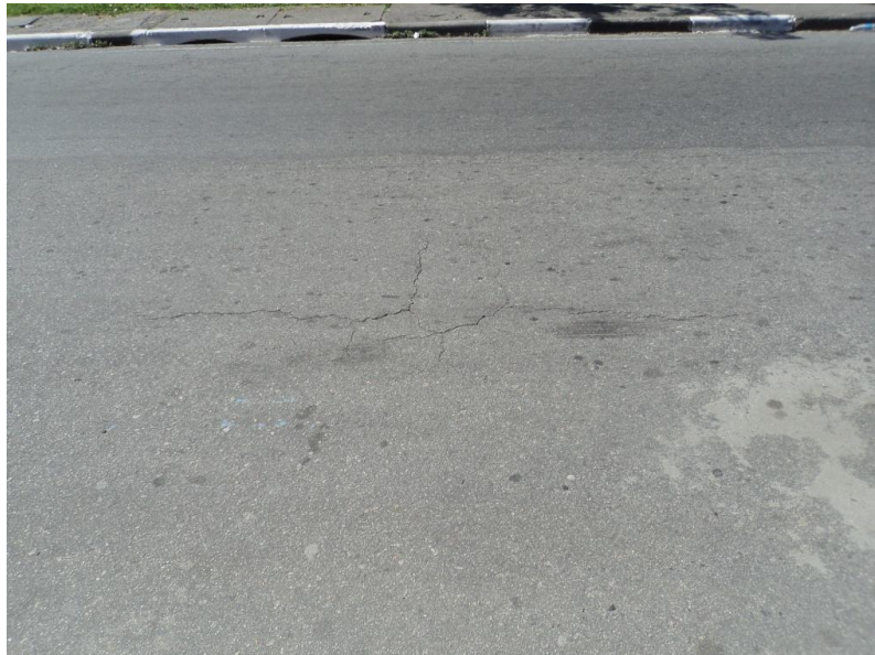
Figura 2.3: Trinca isolada Fonte: PRÓPRIA (2012)
