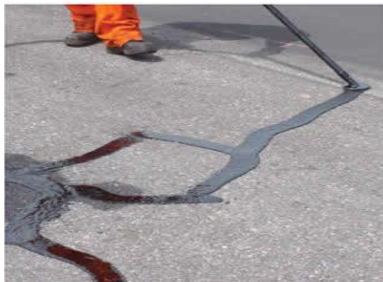
Figura 3.3: Selante sendo aplicado no asfalto Fonte: GOUVEIA (2012)
