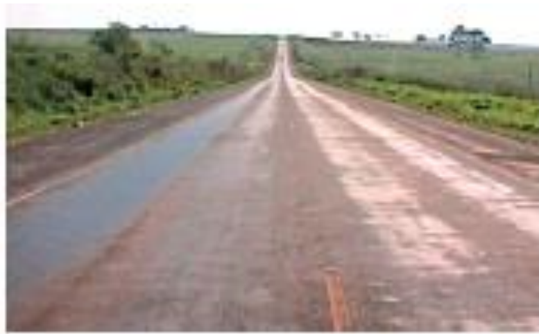
Figura 2.6: Exsudação na trilha de roda Fonte: BERNUCCI, et al. (2008)
