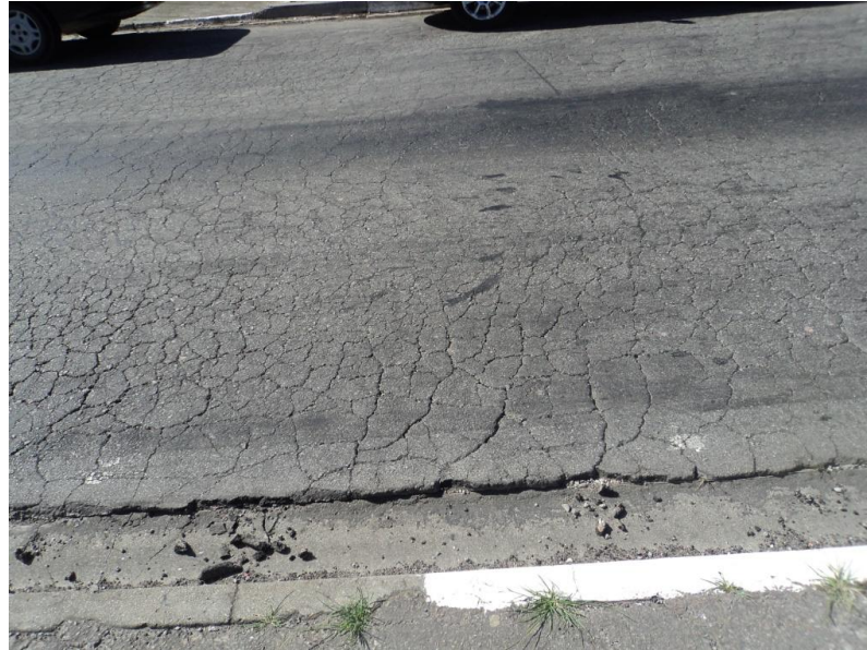
Figura 2.4: Trinca Interligada – Couro de Jacaré(J) Fonte: PRÓPRIA (2012)
