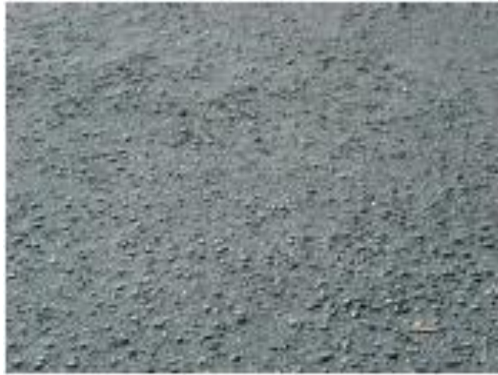
Figura 2.7: Desgaste no revestimento Fonte: BERNUCCI, et al. (2008)
