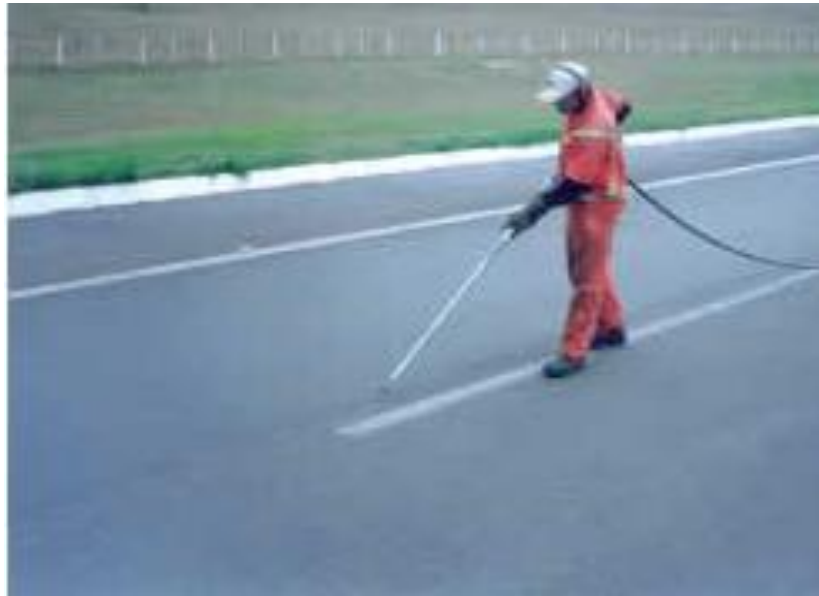
Figura 3.2: Limpeza superficial com jato de ar Fonte: GOUVEIA (2012)
