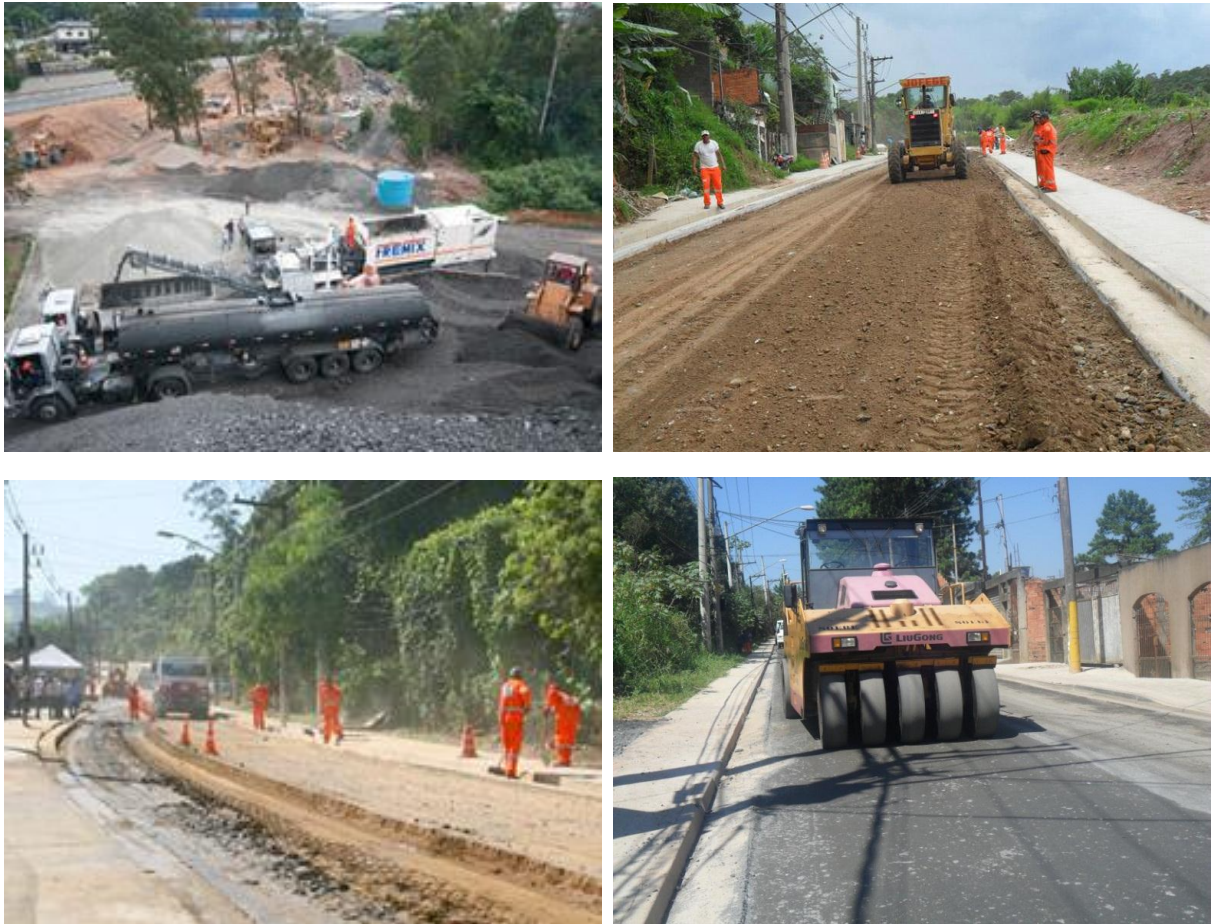
Figuras: 2.12 – Usina de reciclagem móvel de RCD, Av. Sapopemba – SP 2.13 – Pavimentação ecológica, Av. Sapopemba - SP 2.14 – Camadas de base em material reciclado, Av. Sapopemba – SP 2.15 – Compactação do RAP espumado, Av. Sapopemba - SP
