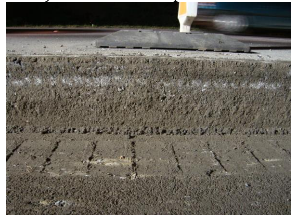
Remoção de 30 cm de pavimento por vez
