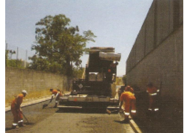
Aplicação do RAP com vibroacabadora
