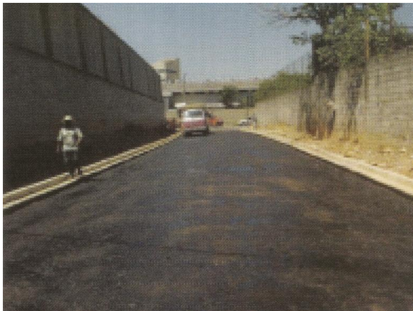
Pintura sobre camada do subleito
