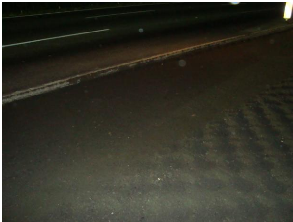
Trecho reparado aguardando revestimento
