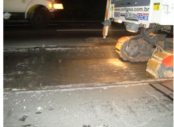
Remoção das camadas de pavimento
