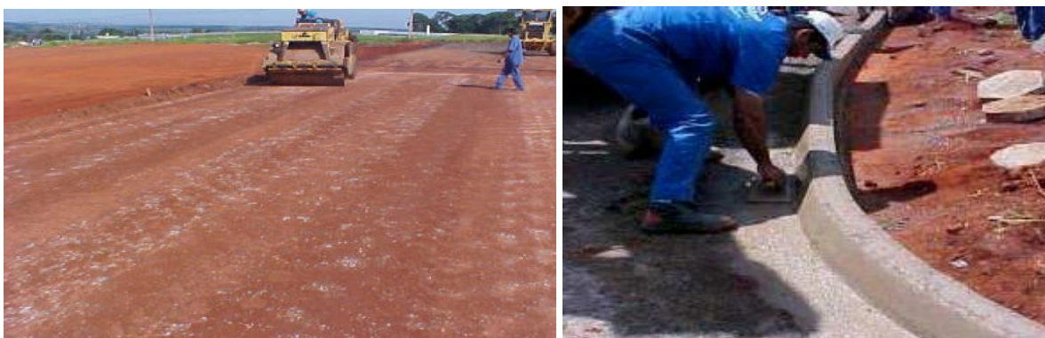
Figuras: 2.21 – Base com agregado reciclado, R dos Ciprestes, Goiânia - GO 2.22 – Meio fio com agregado composto de RCD, Goiânia - GO Fonte: SILVA (2004)
