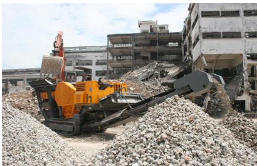
Figura 2.2 – Reciclagem dos RCD no próprio canteiro de obras
