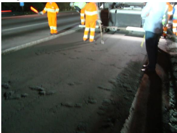
Aplicação do RAP com vibroacabadora
