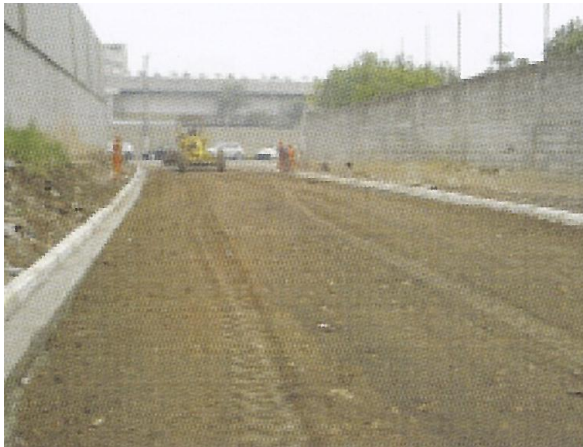
Espalhamento do RCD com motoniveladora
