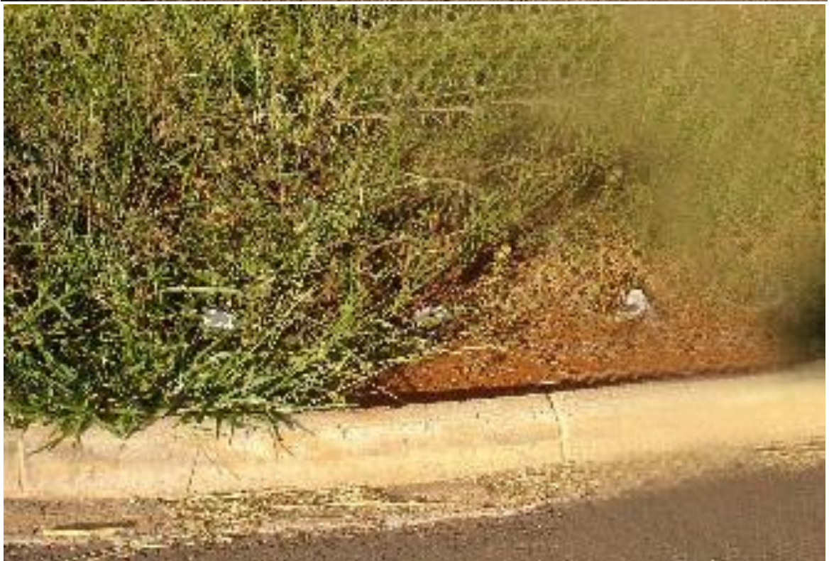
Figuras: 2.23 / 2.24 – Pista, meio fio guias e sarjeta experimental com agregado reciclado de RCD, R dos Ciprestes, Goiânia - GO Fonte: Lima (2009)
