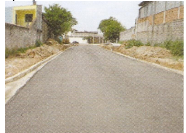
Base pronta para receber o revestimento
