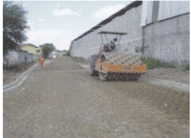
Compactação do subleito de RCD
