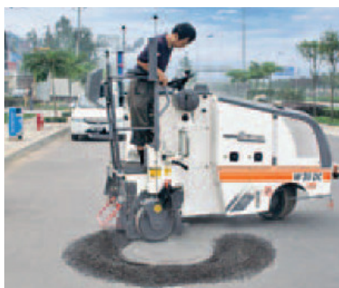
Figura 2.13 – W 50 DC fresando pequeno raio envolto por um poço de visita Fonte: WIRTGEN (2011)
