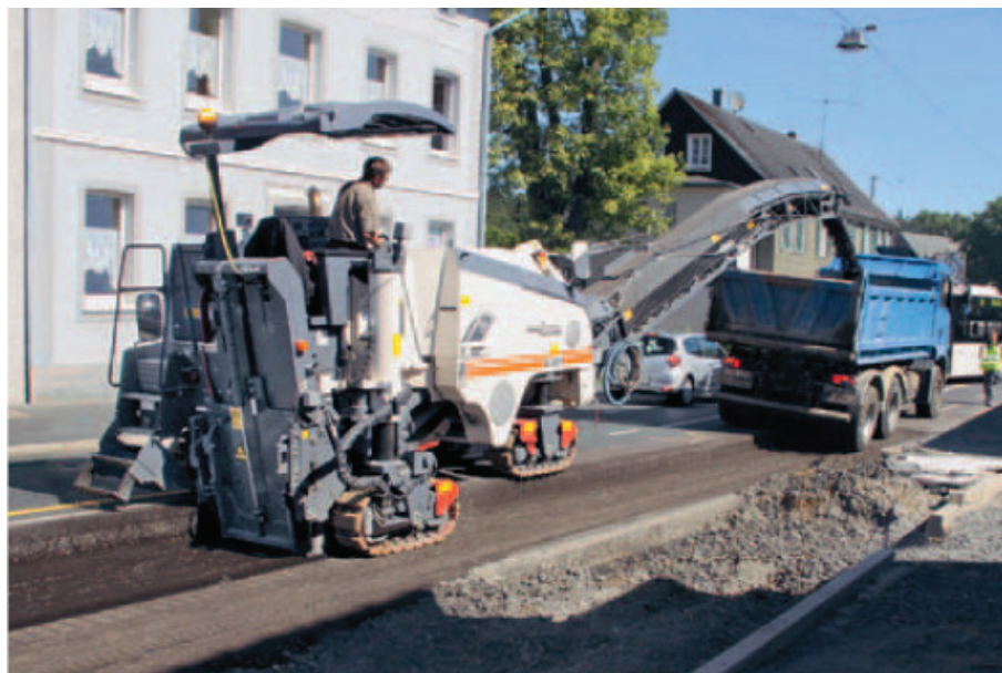
Figura 2.20 – Fresadora W 100 F, da Wirtgen, fresando uma via estreita. Fonte: WIRTGEN (2011)
