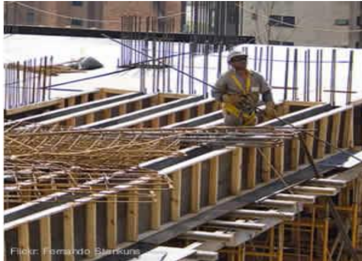
Figura 2.16 - Fôrmas para concreto de madeira
