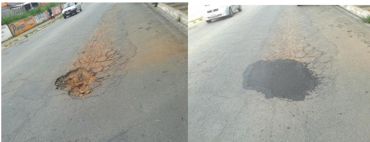
Figura 7.1 - Defeito e procedimento de recuperação na Av. Duque de Caxias - Várzea Paulista.
