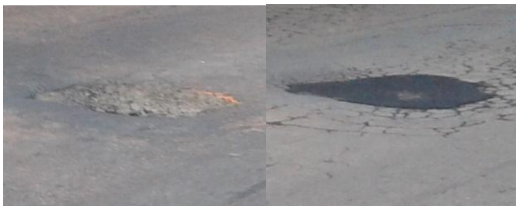
Figura 7.2 - Defeito e procedimento de recuperação na Av. Ipiranga - Várzea Paulista. Fonte: PRÓPRIA (2014)
