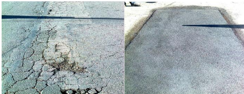
Figura 7.7 - Defeito e procedimento de recuperação na R. Prof. Nelson Álvaro Figueiredo Brito - Jundiaí.
