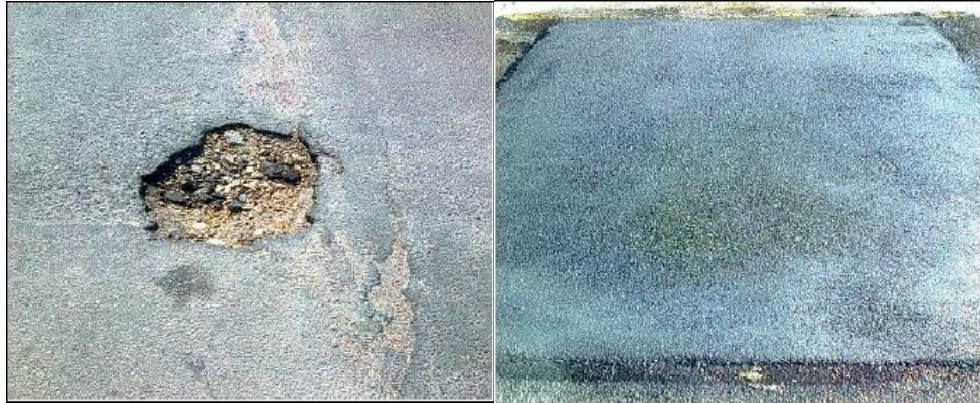
Figura 7.5 - Defeito e procedimento de recuperação na R. Rio Claro - Jundiaí. Fonte: PRÓPRIA (2014)
