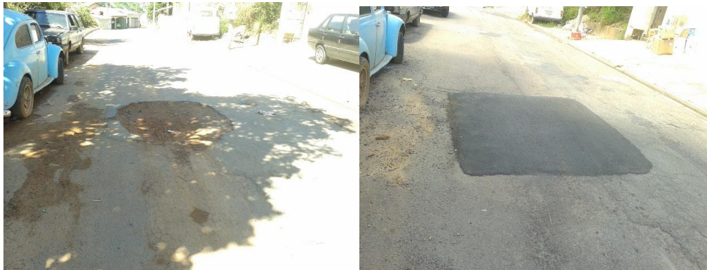
Figura 7.3 - Defeito e procedimento de recuperação na R. Das Dálias - Campo Limpo Paulista.
