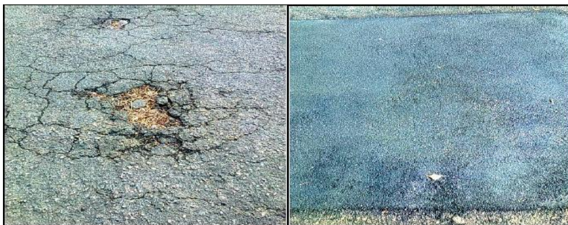
Figura 7.4 - Defeito e procedimento de recuperação na Av. Emilio Antonon - Jundiaí. Fonte: PRÓPRIA (2014)
